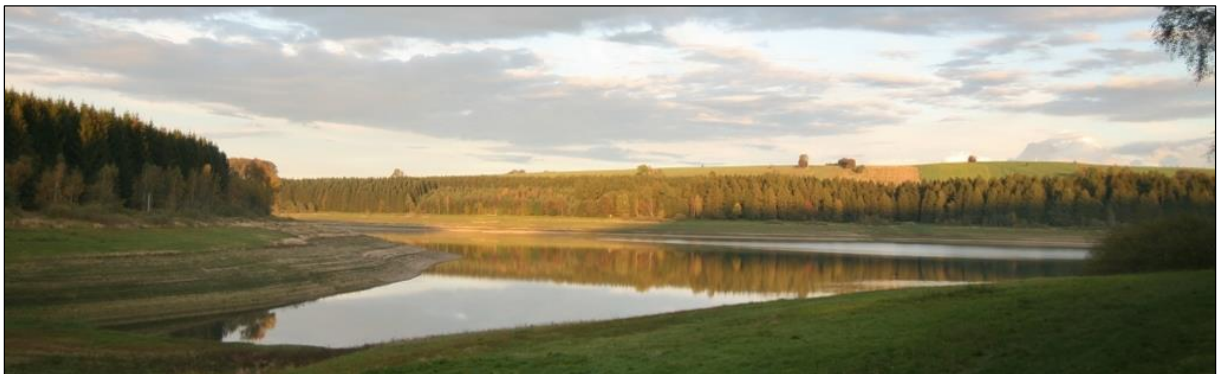
Talsperre Lehmühle im letzten Abendsonnenschein. Foto: Thomas Lehmann
